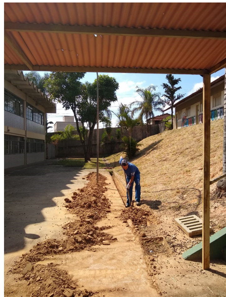
LIMPEZA DE CANALETAS DE DRENAGENS– A FIM DE EVITAR PEQUENAS ALAGAMENTOS
